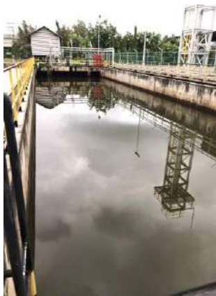
ภาพที่ 2.2-8 บ่อพักน้ำทั้งหมด 1,600 ลูกบาศก์เมตร
